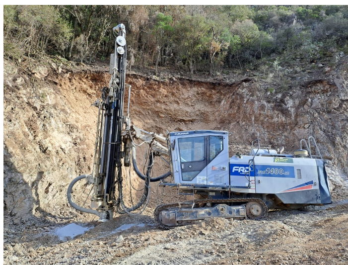
Figura 4.1 – Máquina de perforación hidráulica, perforando en una explotación extractiva.
